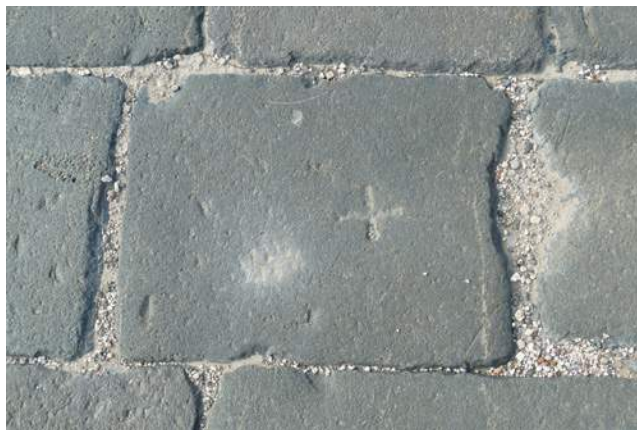
איור 20: צלב על אבן ריצוף מסוּסיתא
