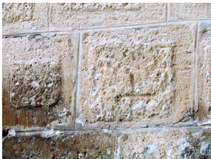
איור 17: הצלב בבריכה בחברון
